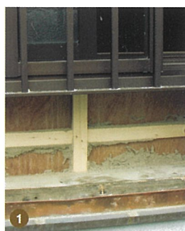
壁の中まで被害が進行します
